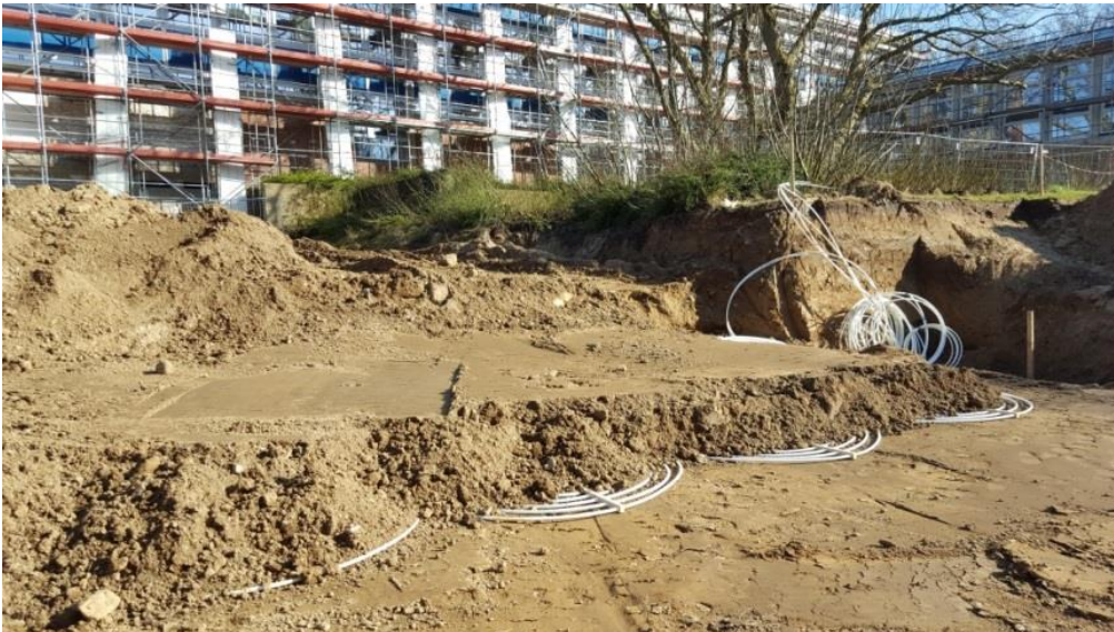
Abbildung 1: Erdkollektor in Sandwichbauweise
