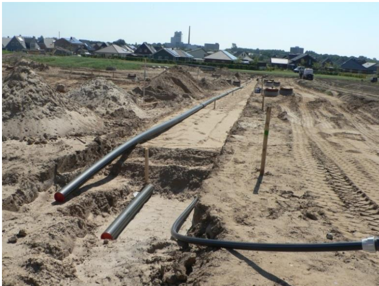
Abbildung 1,2,3: Verlegung Hauptleitung Kalte Nahwärme „Berender Redder“
