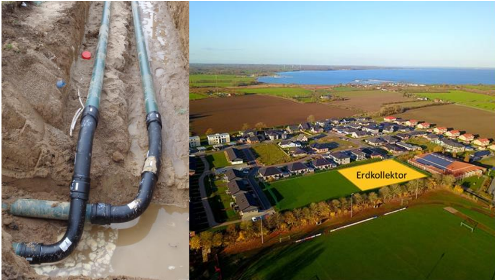
Abbildung 1+2: Kollektorverlegung „Geltinger Bucht“ im Sportplatz
