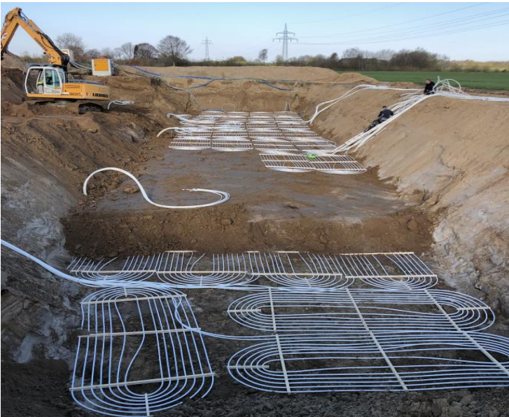
Abbildung 1: Kollektorverlegung „Husby“ unter RRB
