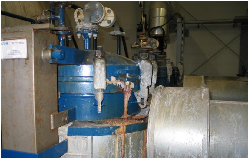
Filterbehälter nach 16 Jahren am Ende seiner Nutzungsdauer
