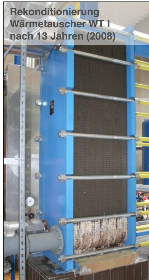
Graue Beläge auf Tauscherplatten (analog 2004)
