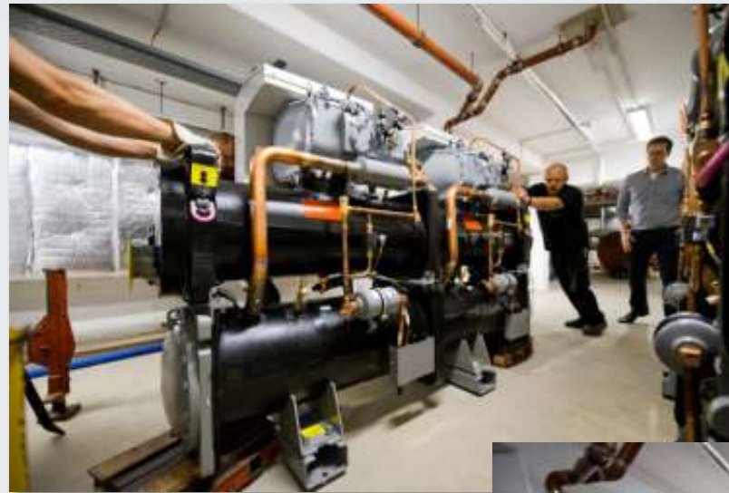
Einbau von zwei Wärmepumpen
