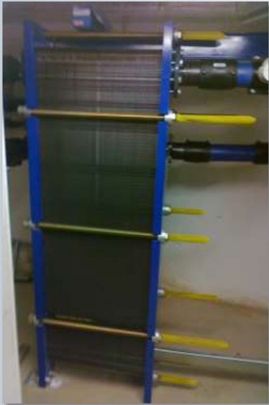
Installation des Wärmetauschers
