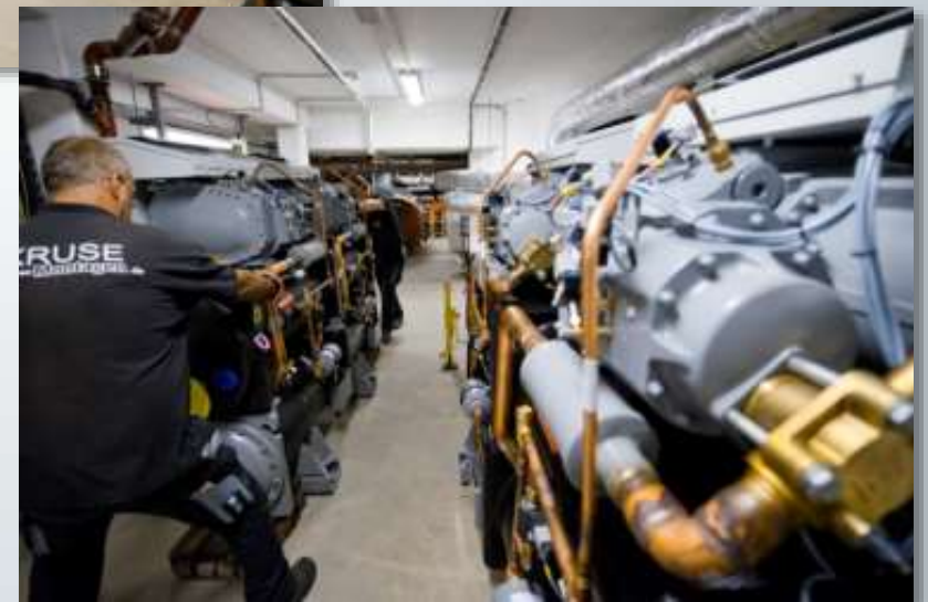
Einbau von zwei Wärmepumpen
